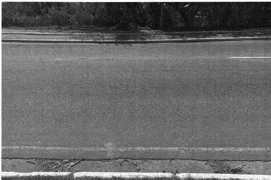
Foto n.º 12 - Aspecto observado da esquerda para a direita – em relação à Foto n.º 10 -, numa posição que será mais bem analisada pelas cinco fotos seguintes. À direita, no meio da foto, depois da calçada, está o final de uma cerca de tela. Vide foto seguinte.
