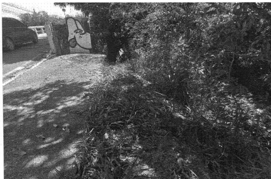
Foto n.º 19 – Detalhe mais à direita em relação à foto anterior. Nesta posição o talude é bem íngreme.
