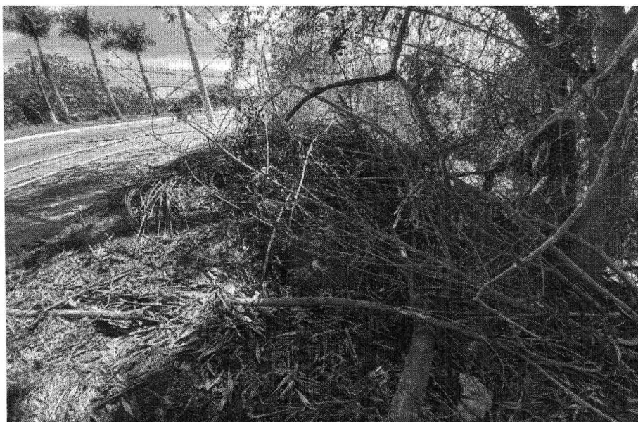
Foto n.º 15 – Aqui pode ser notado o início da inclinação do talude.
