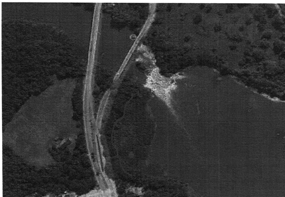
Figura 1 – Fragmento extraído do Google Earth . O destaque em cor na pista é indicativo da posição das fissuras. Notar a linha sinuosa, em cor, que indica aproximadamente o sopé do talude exposto à ação do movimento do curso d’água. Na parte inferior da figura, mais à direita, início do enrocamento desta margem executado há uns 10 anos, hoje tomado pela vegetação.
