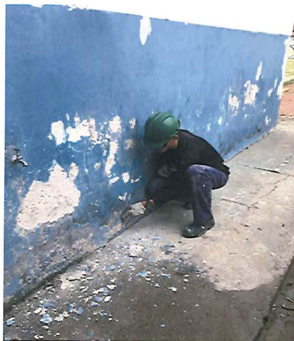
PINTURA DURANTE A MANUTENÇÃO - 25/11/2019 - 13:55)
