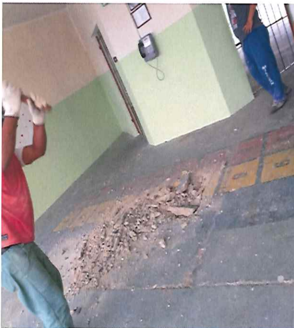
PISO DE CONCRETO DURANTE A MANUTENÇÃO (10/12/2019 - 10:18)
