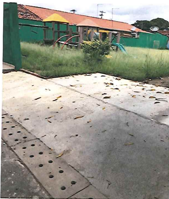
PISO DE CONCRETO APÓS MANUTENÇÃO 02/12/2019 - 09:09)
