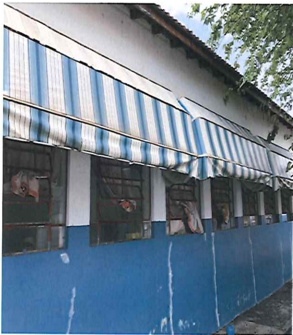
PINTURA ANTES DA MANUTENÇÃO (05/09/2019 - 15:28)
