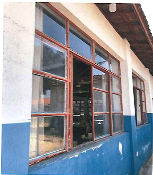
PINTURA DA JANELA ANTES DA MANUTENÇÃO (05/09/2019 15:55)
