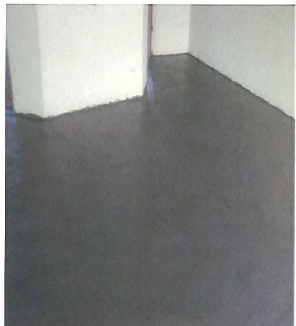
PISO DE CONCRETO APÓS A MANUTENÇÃO - (20/12/2019 - 11:35)
