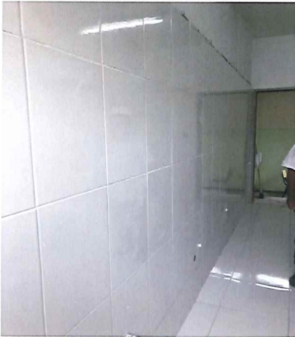
REVESTIMENTO APÓS A MANUTENÇÃO (02/12/2019 - 8:50)
