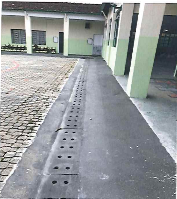
PISO DE CONCRETO APÓS A MANUTENÇÃO (02/12/2019 - 9:00)
