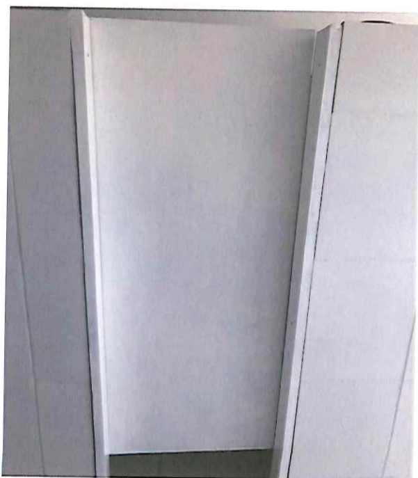
PORTA APÓS A MANUTENÇÃO (30/12/2019 - 16:16)
