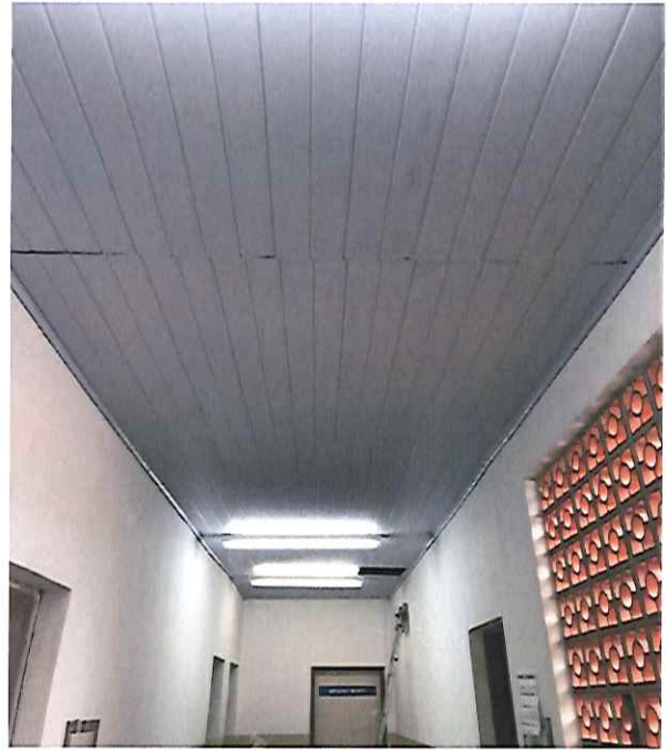
FORRO APÓS MANUTENÇÃO (13/12/2019 - 16:35)
