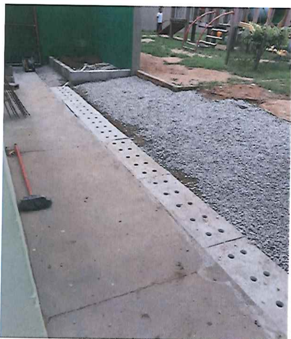
PISO DE CONCRETO DURANTE MANUTENÇÃO (22/11/2019 - 16:49)
