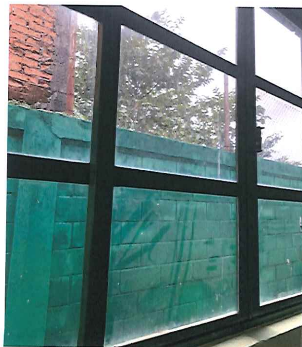
PINTURA DA JANELA APÓS MANUTENÇÃO 28/11/2019 - 15:00)
