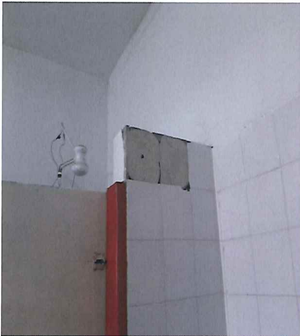
REVESTIMENTO ANTES DA MANUTENÇÃO (05/09/2019 - 14:13)
