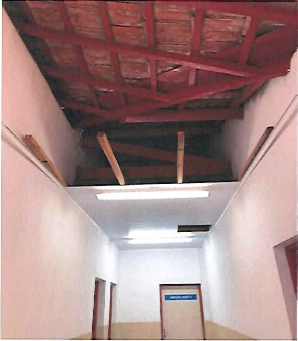
FORRO ANTES DA MANUTENÇÃO (05/09/2019 - 14:07)
