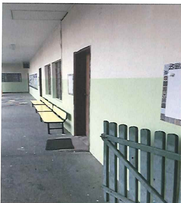
PINTURA APÓS A MANUTENÇÃO (02/12/2019 - 14:42)
