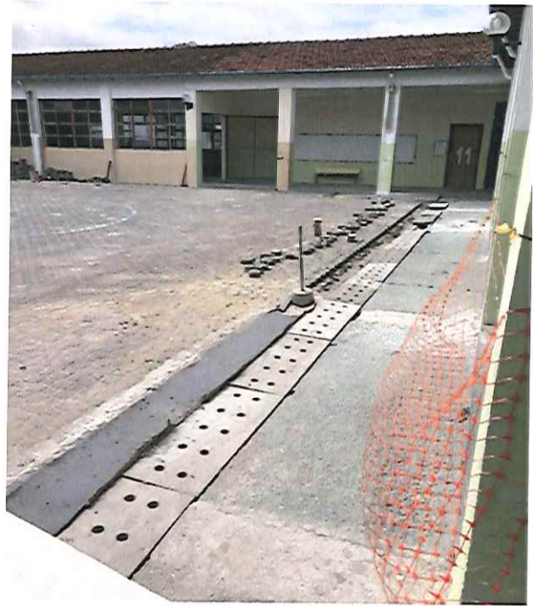
PISO DE CONCRETO DURANTE A MANUTENÇÃO 21/11/2019 - 13:03)
