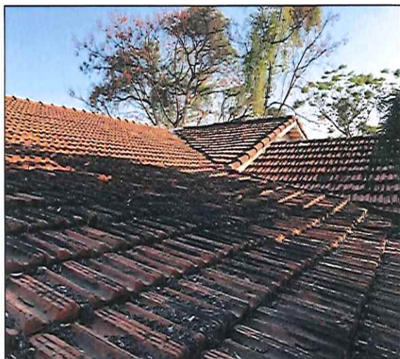
FOTO 01: VISTA DA COBERTURA DO ANEXO PRÓXIMO AO REFEITÓRIO ANTES DA EXECUÇÃO DO SERVIÇO. 29/07/2019 - 16:04
