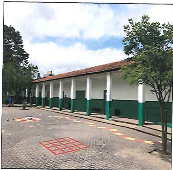
FOTO 15: VISTA DO BLOCO COM A PINTURA FINALIZADA. 20/11/2019 - 09:22
