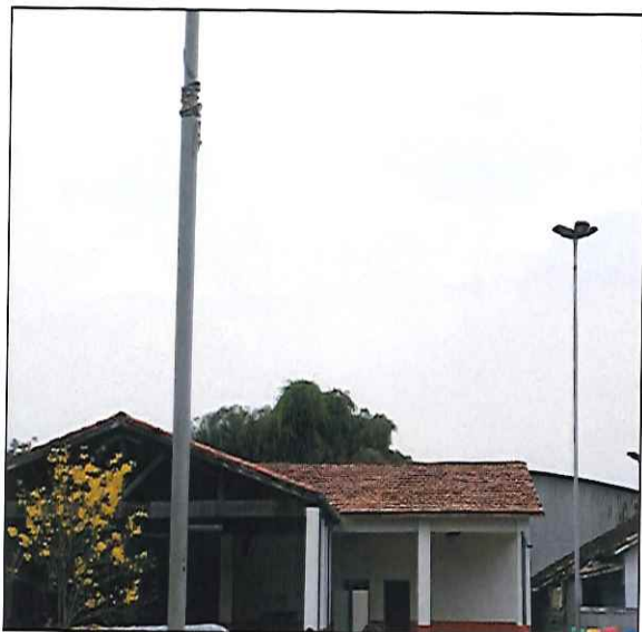
FOTO 11: VISTA DE COBERTURA DO ANEXO PRÓXIMO AO REFEITÓRIO FINALIZADO. 20/09/2019 - 14:37
