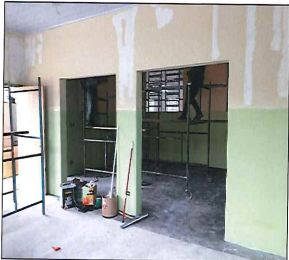
FOTO 09: VISTA DA SALA DO ANEXO PRÓXIMO AO REFEITÓRIO DURANTE A EXECUÇÃO DOS SERVIÇOS. 09/10/2019 - 10:23
