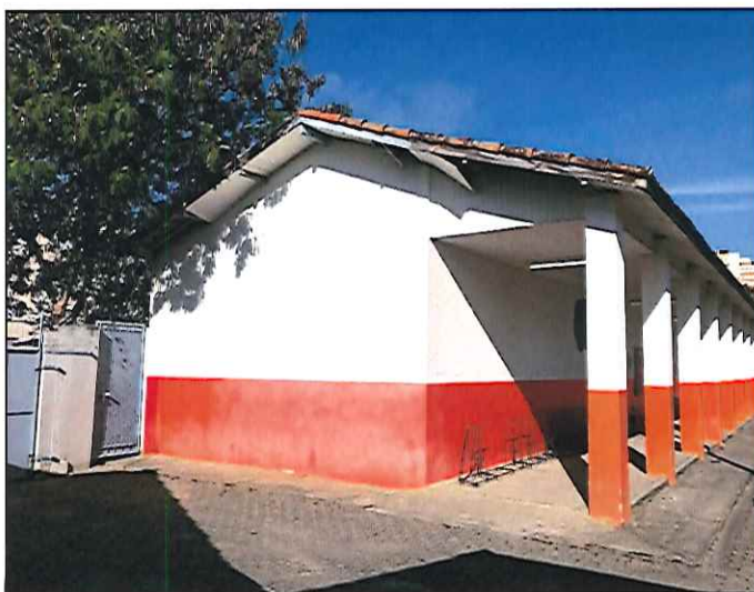
FOTO 04: VISTA DO BLOCO PRINCIPAL ANTES DA EXECUÇÃO DO SERVIÇO. 19/07/2019 - 14:50
