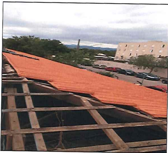
FOTO 13: VISTA DURANTE A EXECUÇÃO DO SERVIÇO NO BLOCO PRINCIPAL. 23/10/2019 - 14:40
