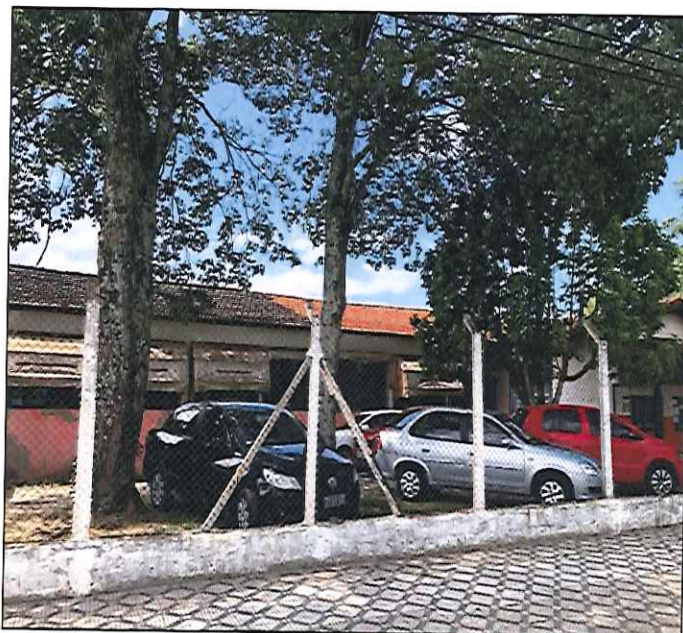
FOTO 14: VISTA DO TELHADO DO BLOCO PRINCIPAL DURANTE A EXECUÇÃO DOS SERVIÇOS. 25/11/2019 - 14:22
