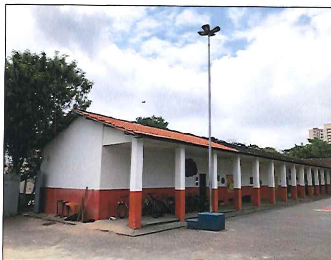
FOTO 12: VISTA DO BLOCO PRINCIPAL COM EXECUÇÃO PARCIAL FINALIZADA. 22/10/2019 - 10:43
