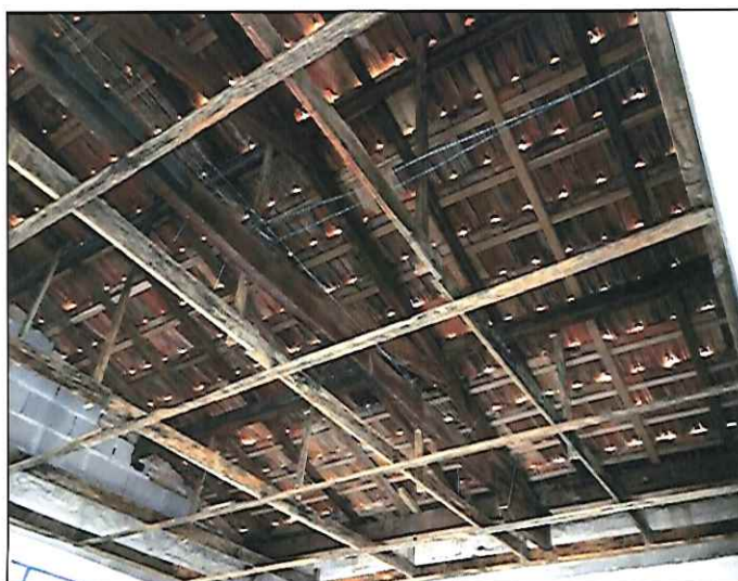
FOTO 08: VISTA DA EXECUÇÃO DO SERVIÇO DE RETIRADA DO FORRO. 27/09/2019 - 10:08
