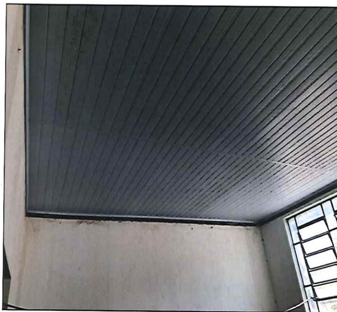
FOTO 10: VISTA DO FORRO INSTALADO. 27/09/2019 - 10:09
