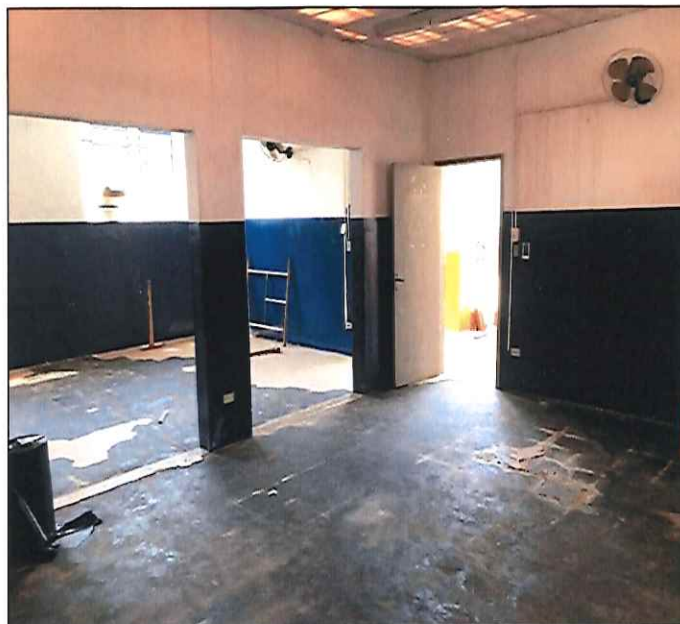
FOTO 06: VISTA DO PISO DURANTE A EXECUÇÃO DO SERVIÇO. 18/09/2019 - 11:16
