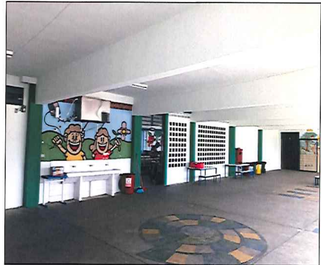
FOTO 06: VISTA DO PÁTIO COBERTO FINALIZADO. 22/10/2019 - 11:08
