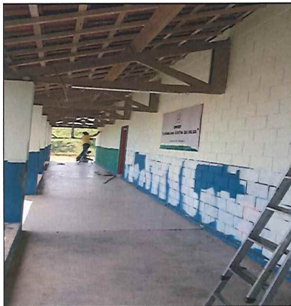
FOTO 03: VISTA DO CORREDOR DAS SALAS DE AULA DURANTE A EXECUÇÃO DOS SERVIÇOS. 26/12/2019 - 14:03
