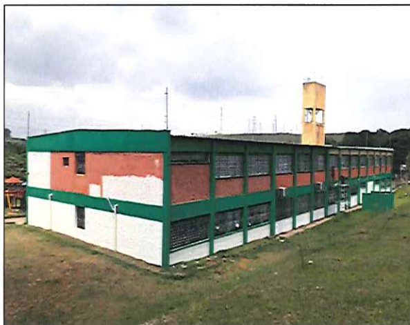
FOTO 04: VISTA PANORÂMICA DO PRÉDIO DURANTE A EXECUÇÃO DO SERVIÇO. 22/10/2019 - 11:10
