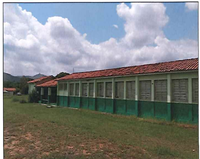
FOTO 04: VISTA DOS SERVIÇOS DE PINTURA FINALIZADOS. 28/12/2019 - 11:22
