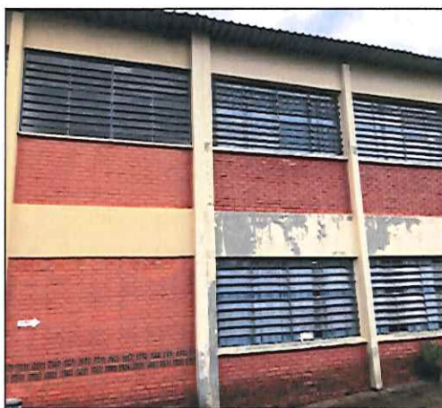
FOTO 01: VISTA LATERAL DO PRÉDIO ANTES DA EXECUÇÃO DO SERVIÇO. 04/09/2019 - 08:56
