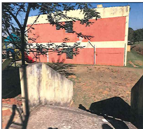
FOTO 02: VISTA DOS FUNDOS DO PRÉDIO ANTES DA EXECUÇÃO DO SERVIÇO. 11/07/2019 - 09:49
