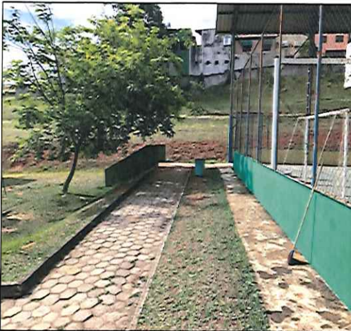
FOTO 07: VISTA DA QUADRA E DO GUARDA CORPO COM A PINTURA FINALIZADA. 31/10/2019 - 15:12
