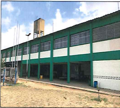
FOTO 05: VISTA DA LATERAL DO PRÉDIO FINALIZADA. 22/10/2019 - 11:09
