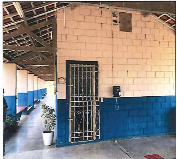
FOTO 02: VISTA DA ÁREA QUE LEVA AS SALAS DE AULA ANTES DA EXECUÇÃO DO SERVIÇO. 25/10/2019 - 12:05
