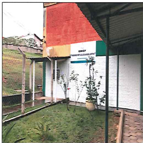
FOTO 03: VISTA FRONTAL DO PRÉDIO DURANTE A EXECUÇÃO DO SERVIÇO. 08/10/2019 - 15:35
