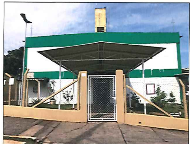
FOTO 08: VISTA FRONTAL DO PRÉDIO COM A PINTURA FINALIZADA. 31/10/2019 - 15:09
