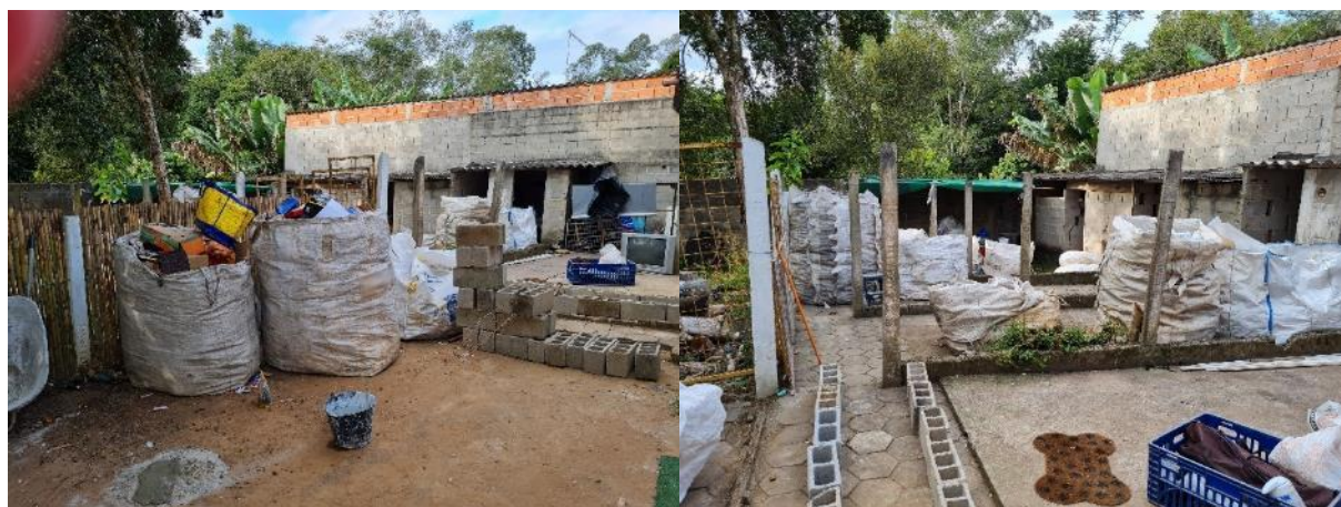
Figura 43: APAS – Local provisório de armazenamento de bags com resíduos já triados
