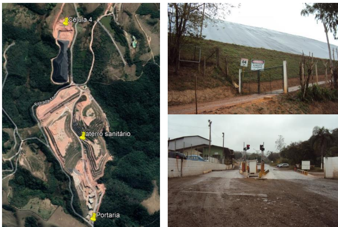
Figura 51: Vista da célula 4 e da Portaria do aterro sanitário, respectivamente
