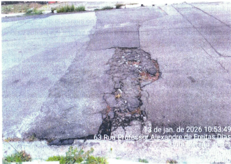
Foto 2: Local com afundamento, deslocamento e fissuração do reparo realizado
