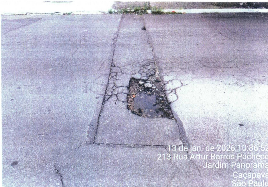
Foto 10: Local com afundamento, deslocamento de via.
