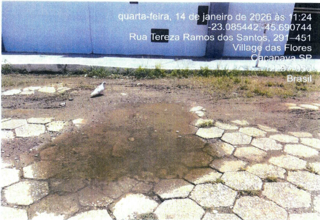
Foto 17: Local com afundamento na via em frente ao hidrômetro
