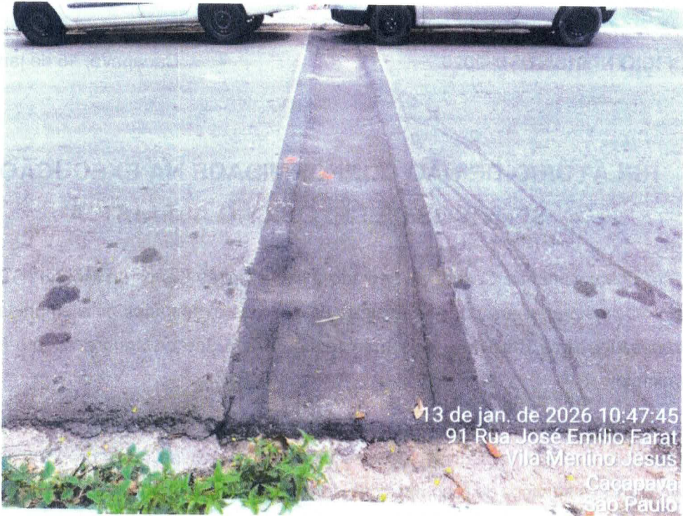
Foto 1: Local com afundamento em reparo realizado
