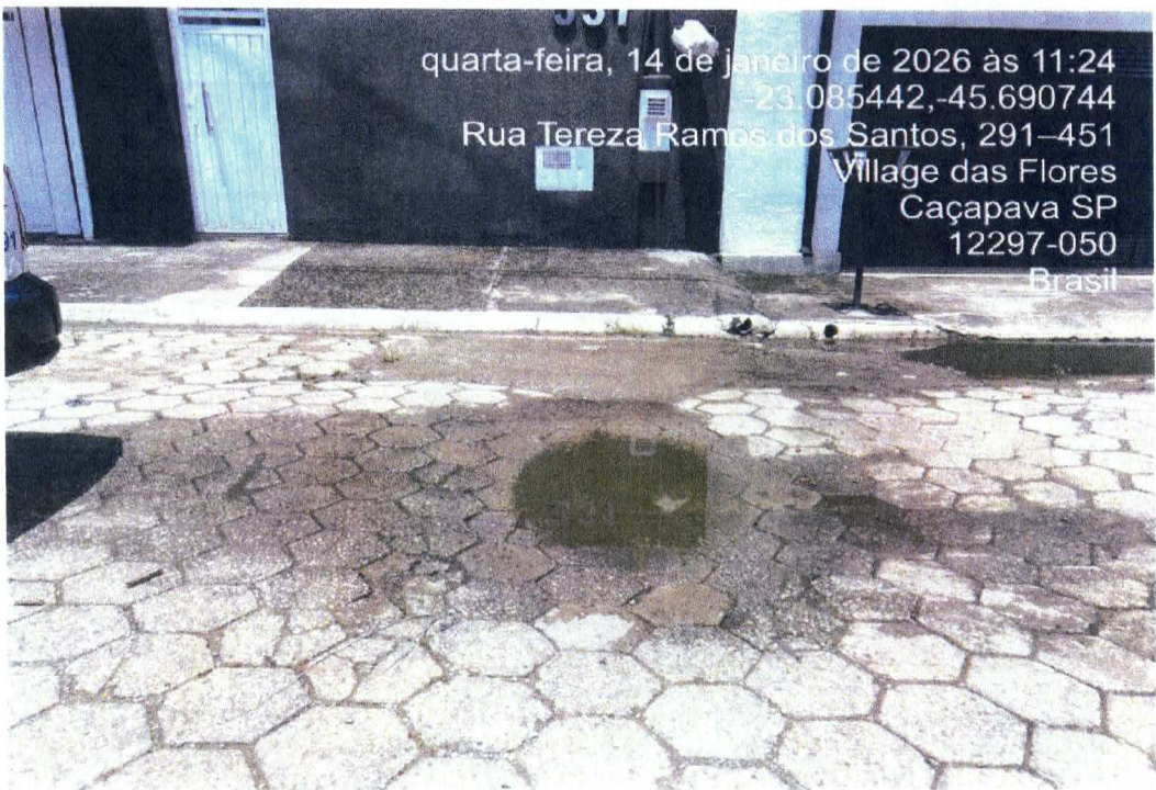
Foto 17: Local com afundamento na via em frente ao hidrômetro
