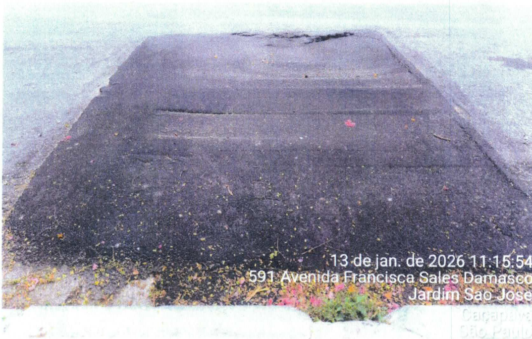
Foto 9: Local com afundamento, fissuração do reparo
