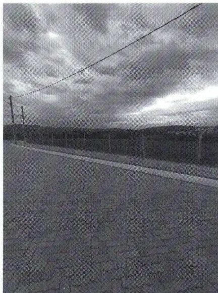
Foto 04 - Terreno com pavimentação de intertravado.
